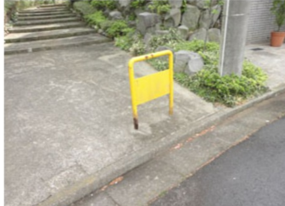
<飛び出し防護柵腐食の例>
