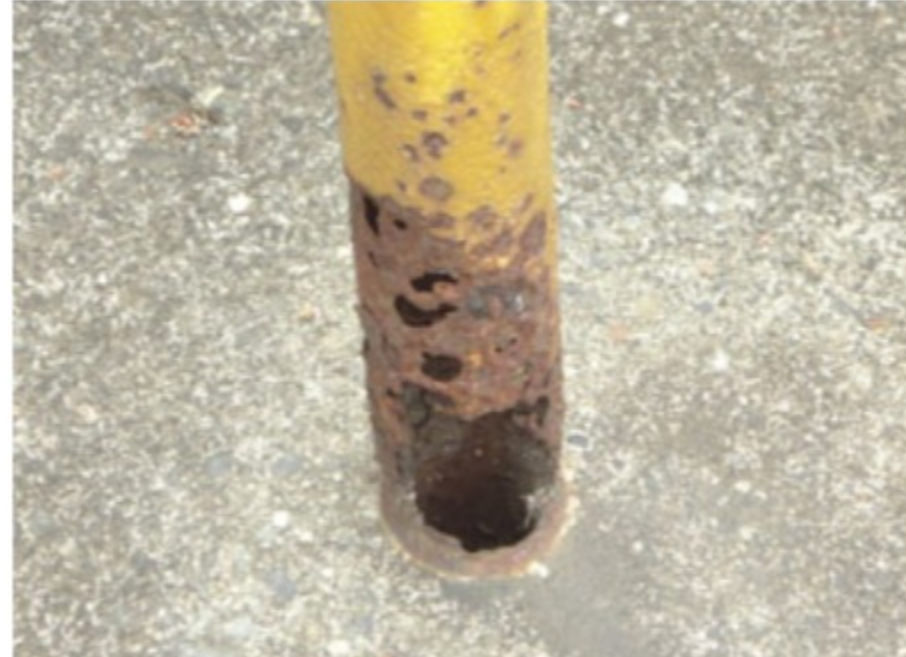
<飛び出し防護柵腐食の例>
