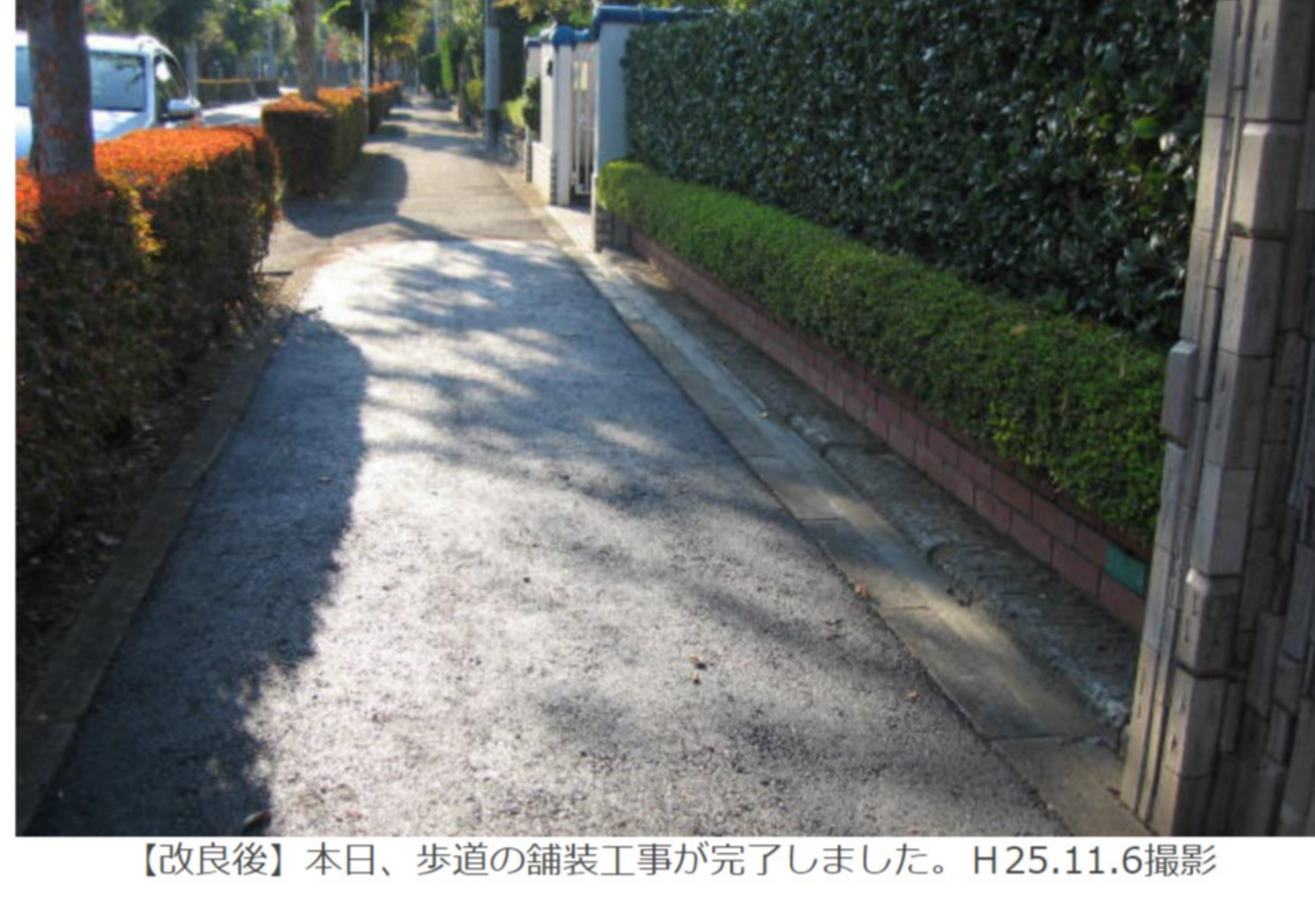
【改良後】本日、歩道の舗装工事が完了しました。H25.11.6撮影
